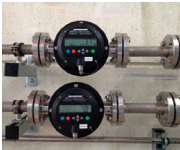
FMO 150 avec raccords à bride, monté sur une conduite.
