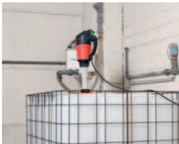
Pompage d'eaux usées galvaniques dans un réseau d'élimination de déchets situé en hauteur.
